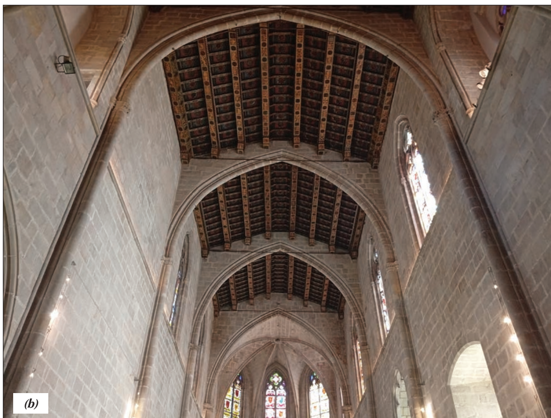
Slika 14: (a) Katedrala v Sevilli – odkriti oboki so ojačani s pomočjo prečnih zapolnjenih lokov in (b) Palatin-ska kapela v Barceloni – zapolnjeni loki so uporabljeni v kombinaciji z odkritim ostrešjem (Foto: L. Pulević).
